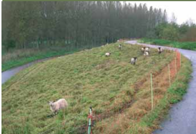
De dijken worden onderhouden door grazende schapen, de stukken zijn met verplaatsbare bedrading afgebakend.
