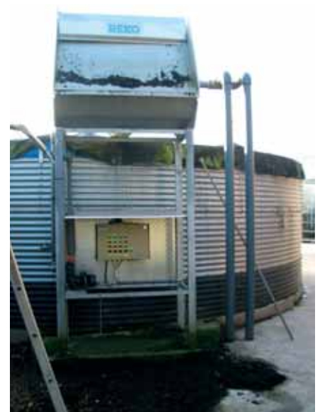
De containerteelt en de recyclage van het water zorgt voor een gesloten systeem. Ziektekiemen worden er met een zandfilter uit gehaald.
